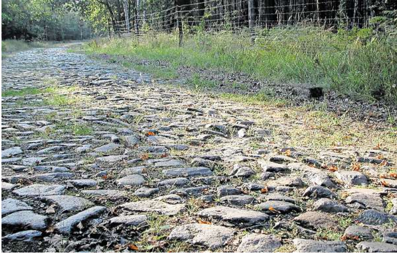
So sieht der Kopfsteinpflaster-Belag auf der 3,7 Kilometer langen Schlechtwegstrecke zwischen Gottow und Kummersdorf-Gut aus.
