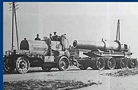
Der Benzin-elektrische Antrieb ist in den Anfangsjahren des 20. Jahrhunderts lange Zeit die erste Wahl zum Ziehen solcher Lasten
