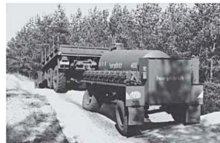
Bei der Funktionsmustererprobung muss der Tankanhänger HL 50.45/2 beweisen, wie gut er über die Verwindungsbahn hinterherläuft
