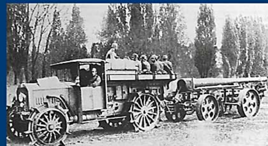
Mit 100 PS und Vierradantrieb setzt die Daimler K.D.I. im Jahr 1917 die Maßstäbe in Sachen Zugkraft. Von einem Verbrennungsmotor angetrieben, schleppt sie die Kanone
