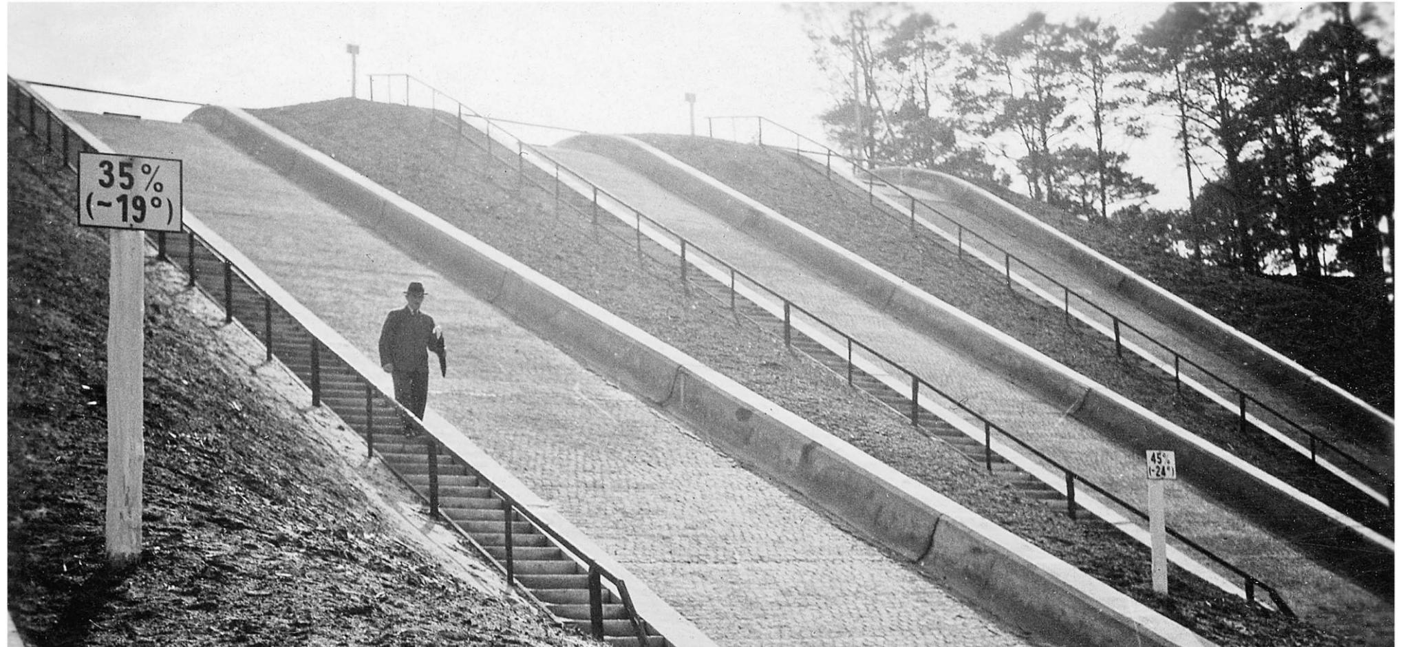
Osterspaziergang im Jahr 1942. Die Steigungsbahnen bilden das größte und bekannteste Testmodul der Verkehrs-Versuchsanlage. Im Bild sind die drei steilsten Strecken.
