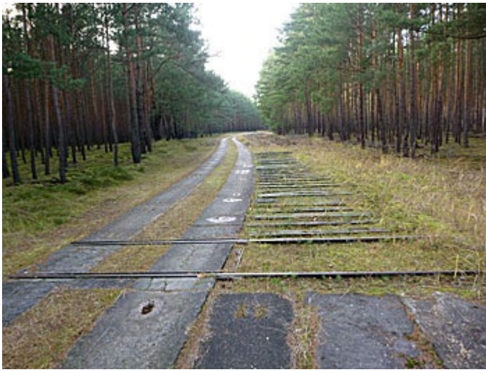
Ein Gleisübergang (Normalspurweite 1435 mm) mit einem niveaugleichen und einem etwa 7 cm frei liegenden Gleiskopf. Unmittelbar dahinter schließen sich über 21 m Länge 34 Bahnschwellen (Abstand ca. 35-45 cm) mit ebenfalls etwa 7 cm Freistand an.
