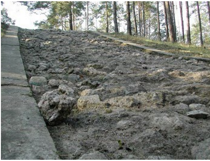
Fester Geröllhang*): Steigung bis 35 %, Breite: 5,00 m, Länge: 35 m, Belag: Geröll, faust- bis kopfgroß in Beton fixiert
