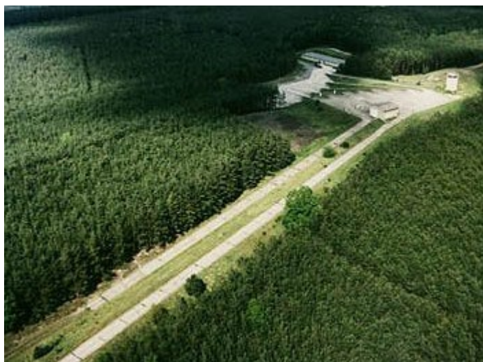
Steigungsbahnen*) mit 5 % und 10 %, Breite: 4,50 m, Bahnlängen: 294,5 m und 151 m, Fahrbahnbelag: Betonplatten (Foto: BAM)
