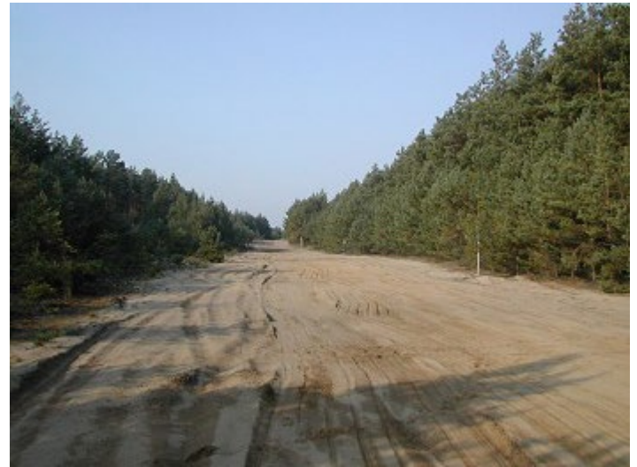
Lockersandstrecke (Meßstrecke): Länge 1000 m mit Wendemöglichkeiten, wechselnde Sandtiefen und Festigkeiten in Abhängigkeit von Witterung und Befahrung
