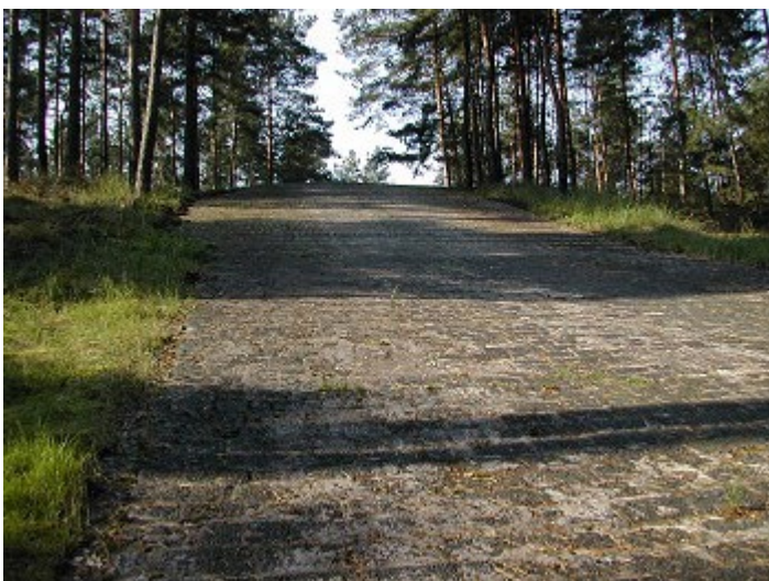
Betonkuppe*): Fahrbahn: unten Schlackesteinpflaster, oben Granitpflasterstreifen in Beton, Steigung max. 28 %, Breite: 7 m, Länge: 70 m
