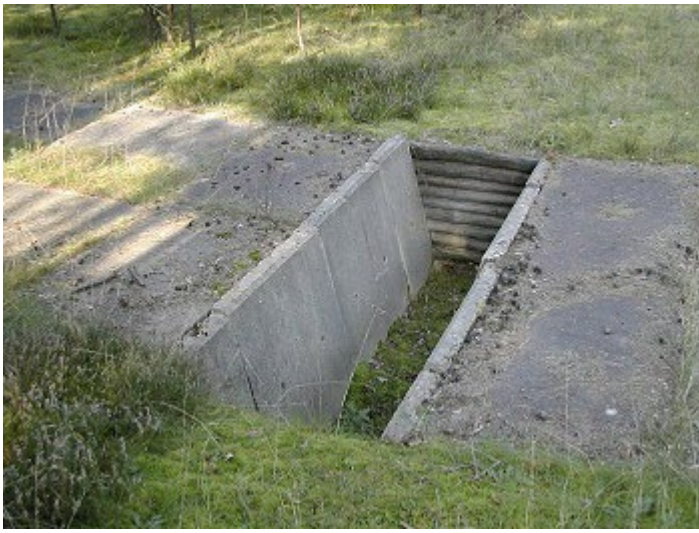
Grabenüberfahrt: Drei Gräben (Tiefe: 1 m, Weite oben: 1 m) im Abstand von etwa 13 bzw. 15 m (Nutzung auf Anfrage)
