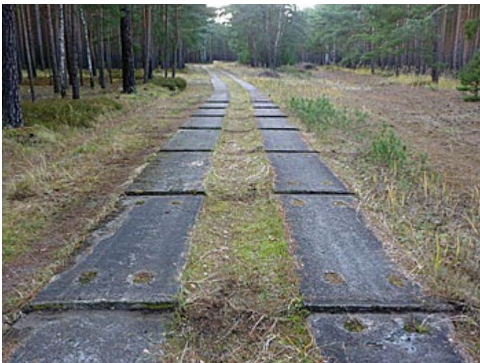
In einem Plattenfahrweg (Einzelplatte 3 m x 1 m; Zwischenraum 0,85 m) sind zwei Schlechtwegstrecken für Rüttelbeanspruchungen eingebaut; hier über 7 Platten verteilt ein symmetrischer Fugenversatz.
