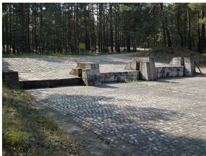
Kletterstufen*): Steighöhen mit 0,40 m, 0,60 m und 0,80 m, Breite: 4,00 m, Variation der Steighöhe durch Balkenauflagen bis max. 1, 20 m
