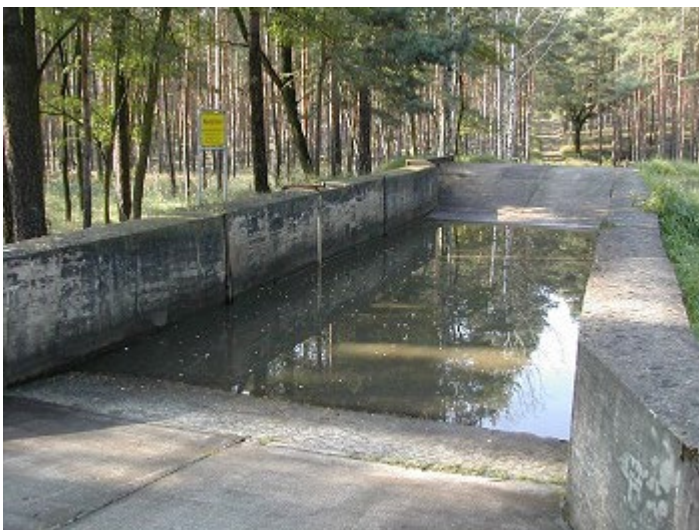
Wasserdurchfahrt*): Wassertiefe max. 1,50 m, Beckenbreite: 5,5 m, Beckenlänge: 31,4 m, Beckengrund: Granitpflaster in Beton
