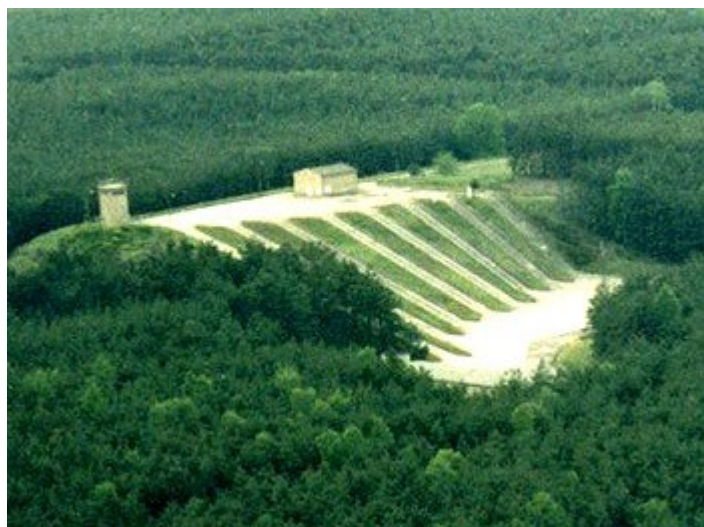
Steigungsbahnen*) mit 15, 20, 25, 30, 35, 45, 55 und 65 % (v.l.n.r.), Breite: 4,20 m, Bahnlängen: 103, 79, 64, 56, 50, 42, 36 und 32 m, Fahrbahnbeläge: Betonplatten, ab 30 % Granitpflaster in Beton gesetzt, ab 45 % Pflastersteine zusätzlich angekippt (Foto: BAM)
