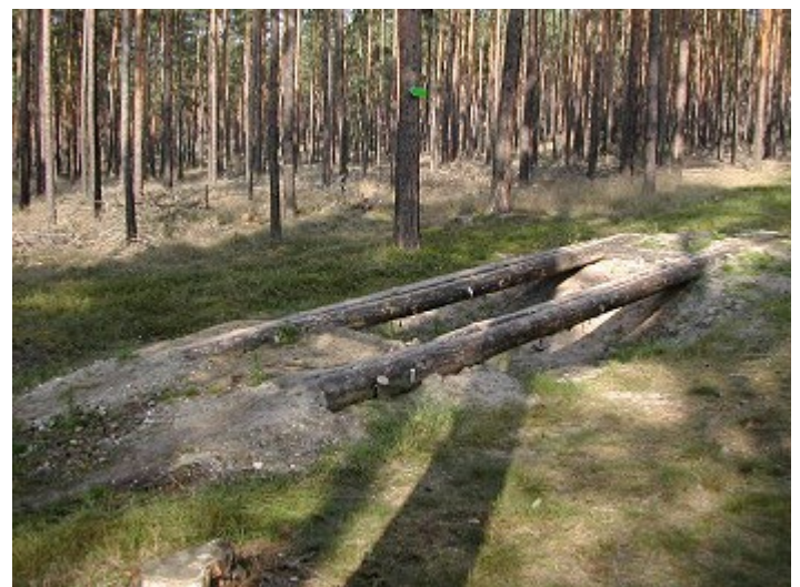
Grabenüberfahrt, ausgelegt für SUV
