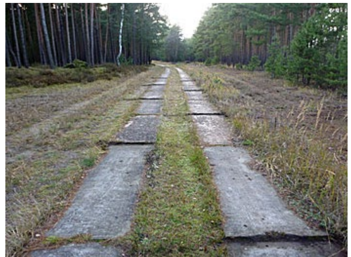
Etwa 30 m weiter im gleichen Plattenweg: Schlechtwegstrecke mit unsymmetrischen (versetzte) Fugenversetzungen von ebenfalls etwa 4 cm Kantenhöhe jedoch über 16 Plattenlängen verteilt.
