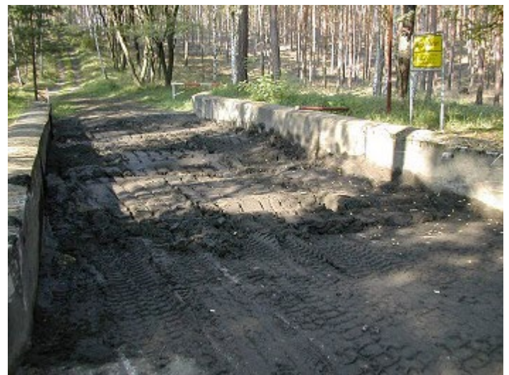
Schlammdurchfahrt*): Sumpftiefe max. 0,5 m, Beckenbreite: 5,5 m, Beckenlänge: 28,3 m; Beckengrund: Granitpflaster in Beton
